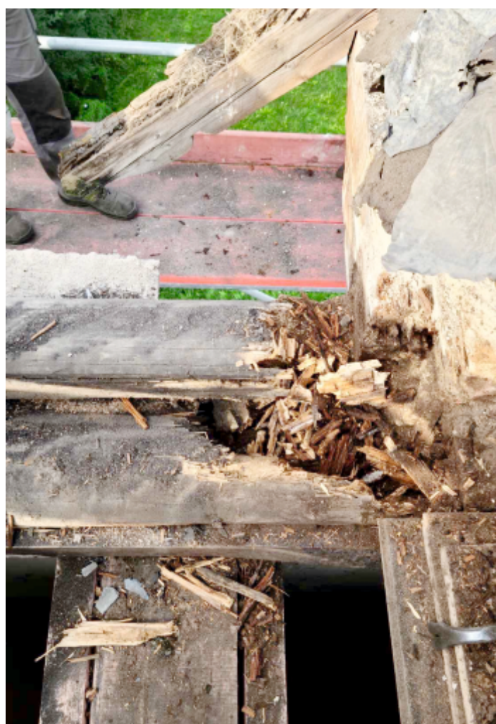
Rekonstrukce střechy hasičárny začala doslova po 12. hodině
