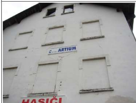
3. Štítová stěna poškozená trhlinami
